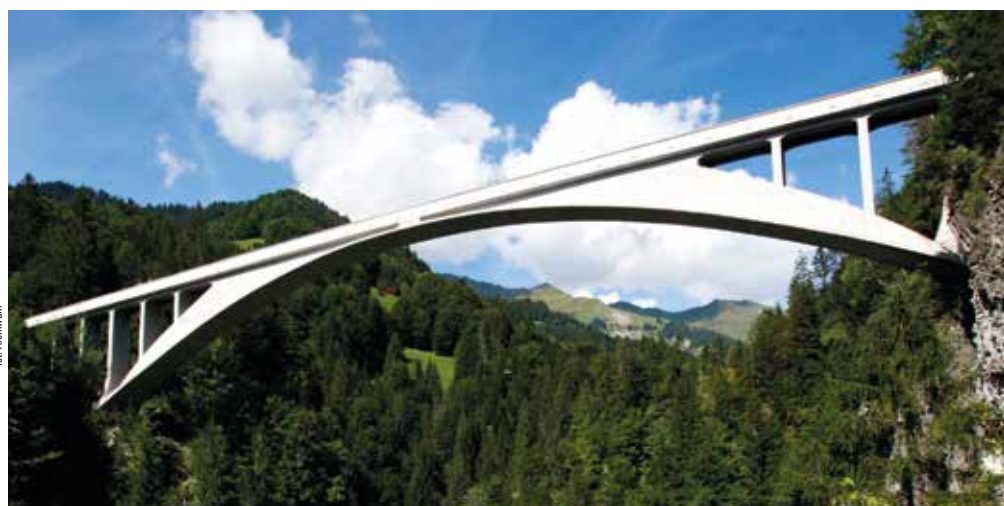
Rys. 11. Most Salginatobel, rozpiętość 90,0 m, 1930 r. [12]
