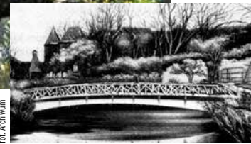
Rys. 6. Most Chazelet, 1875 r. zbrojony wg patentu J. Moniera – rozpiętość 13,8 m, Chazelet, Francja [8, 9]
