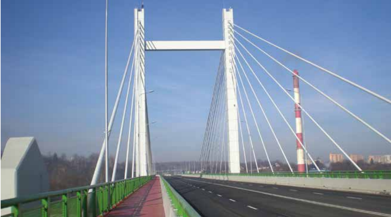
fol. Archiwum budowy mostu w Przemysku, Mota-Engel/CE SA
