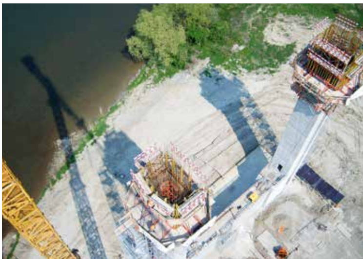
fol. Archiwum budowy mostu w Przemysku, Mota-Engel/CE SA
