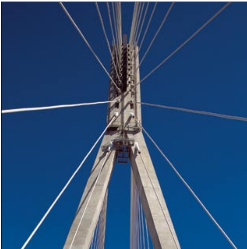
Każde zaczepienie liny na górze musi być wyprowadzone pod innym kątem – jest to bardzo trudne do wyznaczenia, najpierw dla projektanta, a potem dla wykonawcy. Dzięki tym linom most jest widowiskowy, ma niezwykle smukłą linię
